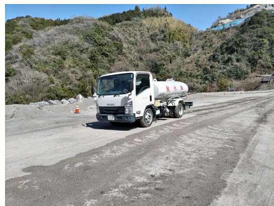
散水車による工事区域内での散水
