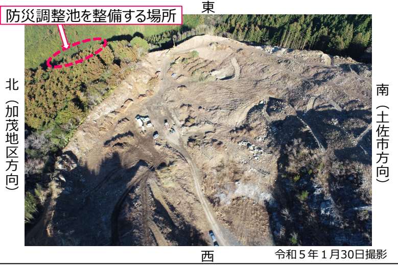
工事区域を上空から見た状況
