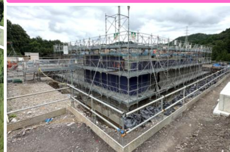
浸出水処理施設（地下階）
