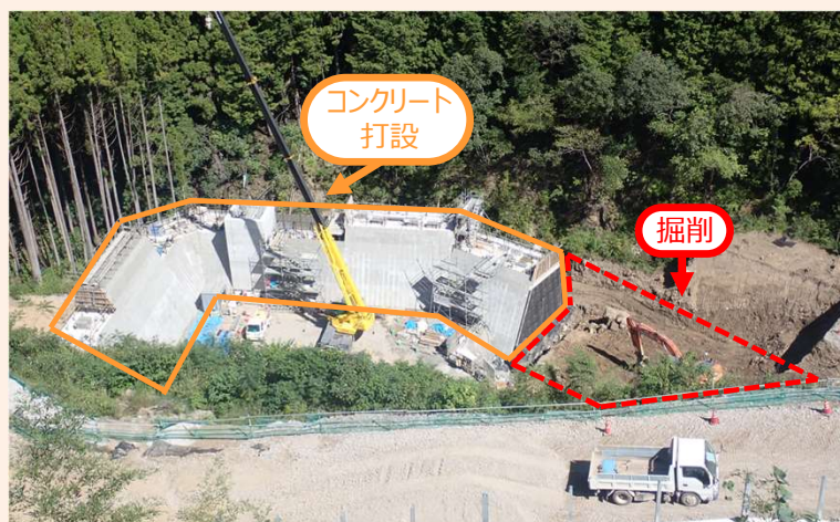
防災調整池の施工状況（令和7年10月9日撮影）
