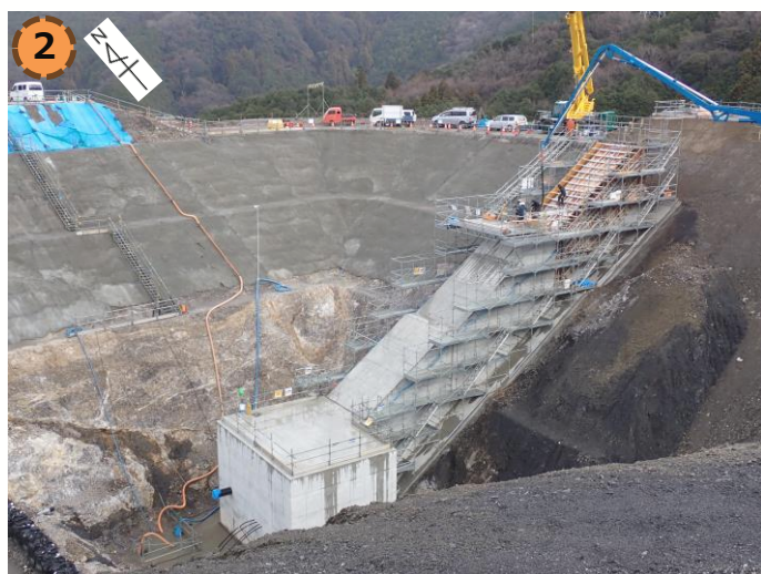
集水ピットの整備状況（令和7年1月9日撮影）
