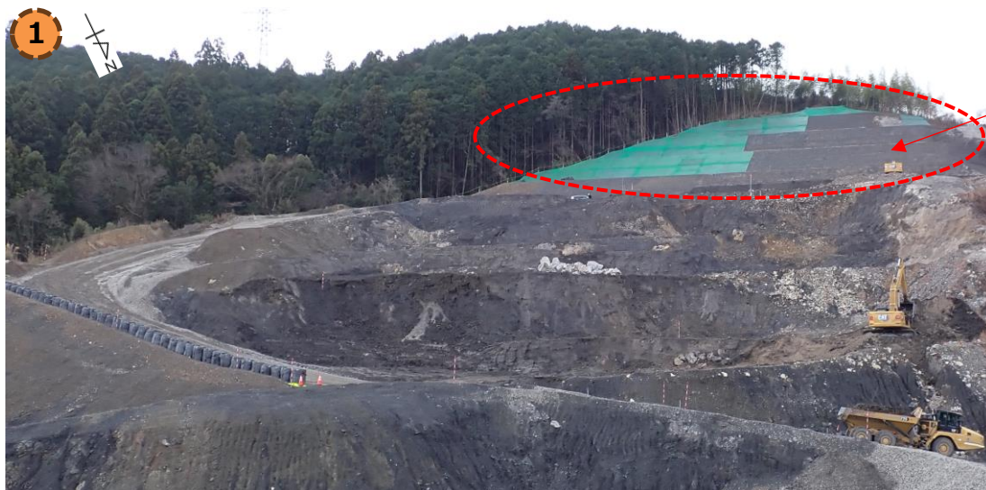
南側斜面の掘削及び改良土盛土の施工状況（令和7年1月9日撮影）
