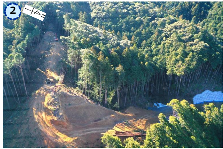
進入道路の整備状況（令和7年1月16日撮影）
