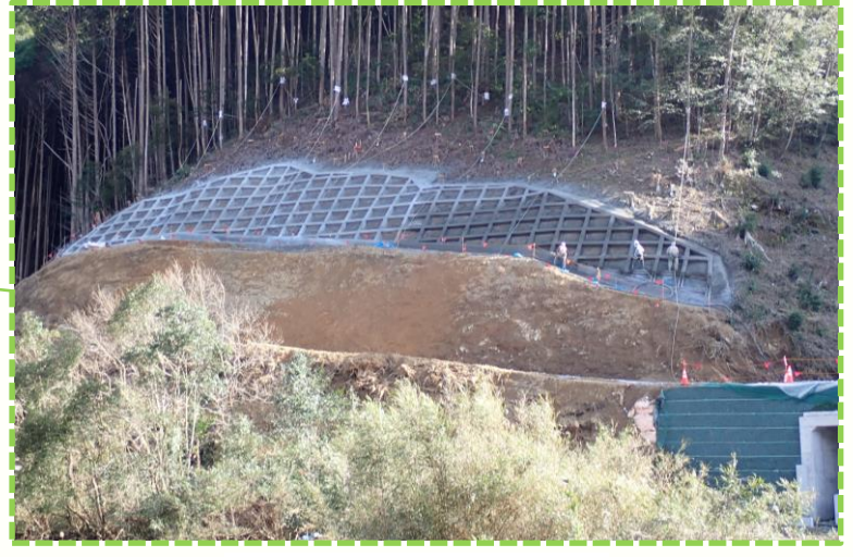
吹付法砕工の施工状況 (令和6年3月8日撮影)
