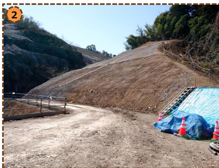
処分場予定地北西側の斜面 (令和6年3月10日撮影)
